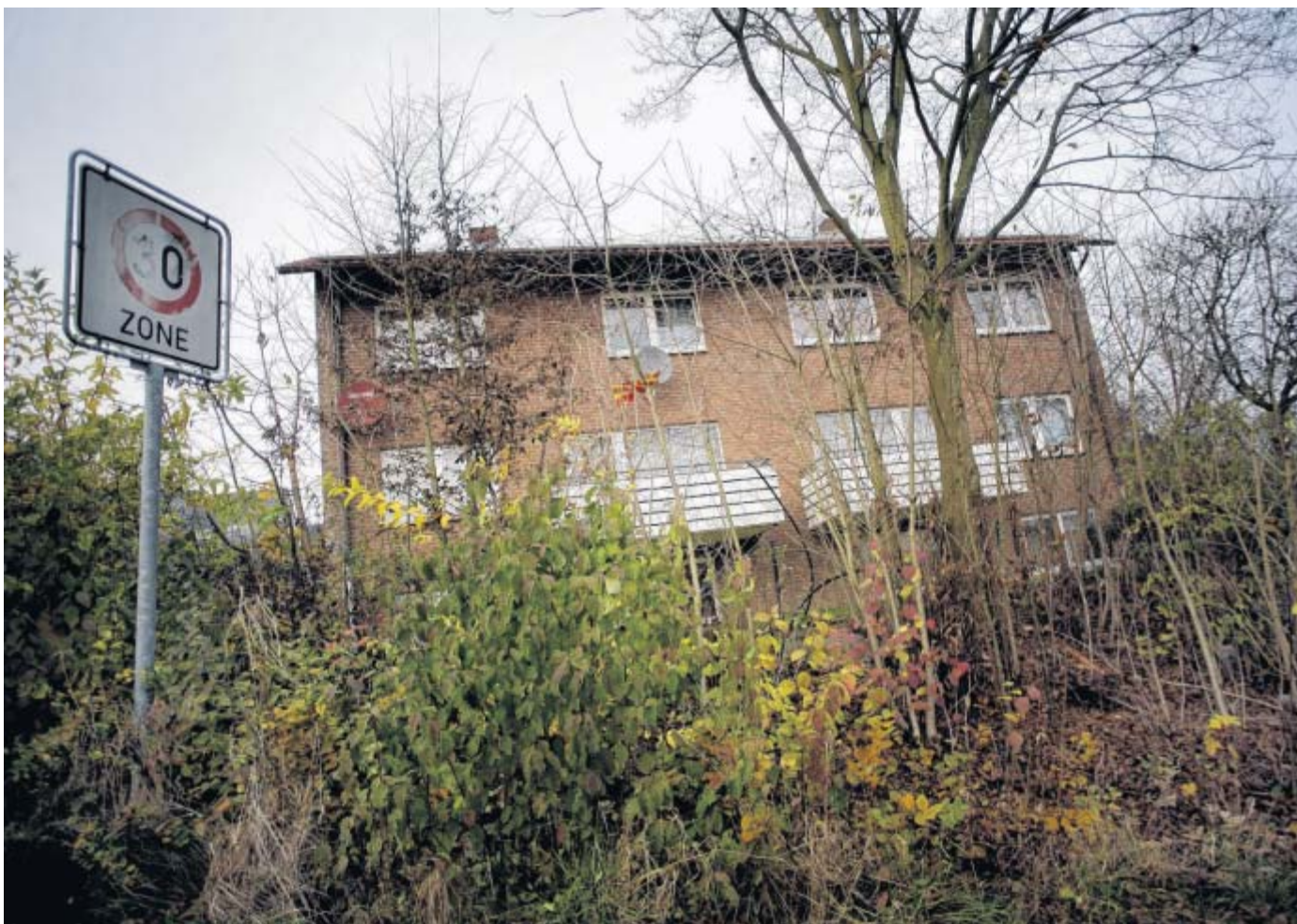
Eine der Unterkünfte: Das Flüchtlingshaus in Oberbauerschaft. Nun müssen weitere Wohnräume gesucht werden.
